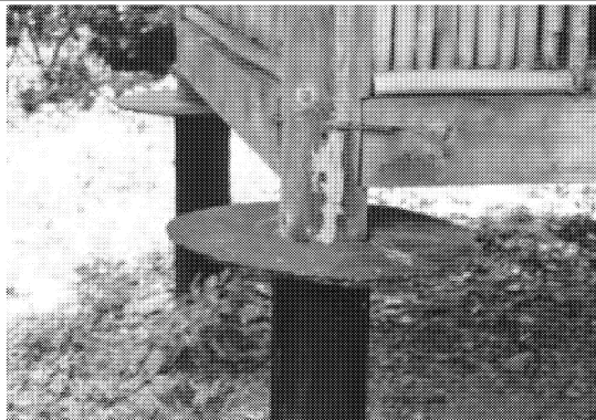
圖 19：穀倉的防鼠設計（圓盤石板可防老鼠爬上穀倉） 資料來源：謝政道攝於 2004/08/09
