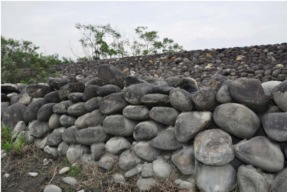
圖 4-1：日治時期客家農民開闢南隆農場期間所堆砌出來的礫石堤防，象徵新移民的集體生活智慧。（李淑芳拍攝）
