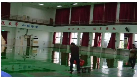
說明：PU 刨除施工情形
