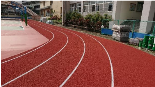
說明：PU 跑道鋪設完成
