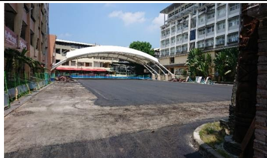
說明：PU 刨除及鋪設球場瀝青
