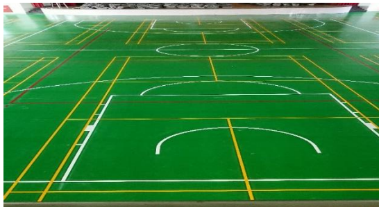
說明：PU 鋪設完成
