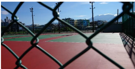
說明：PU 鋪設完成
