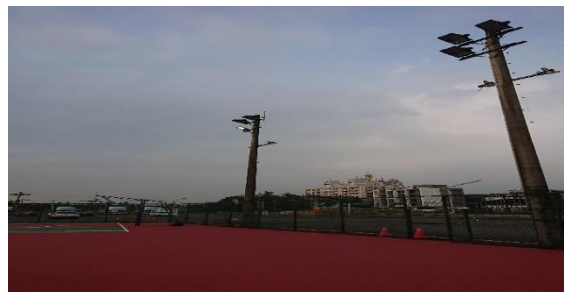
說明：夜間照明完成
