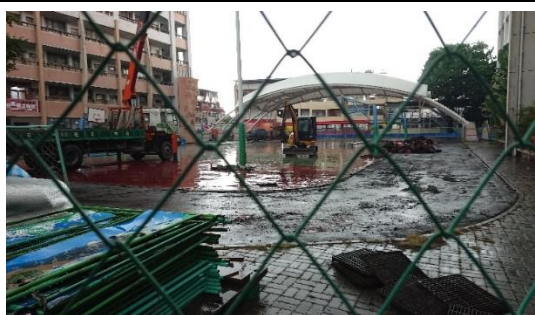
說明：雨天暫停施工情形
