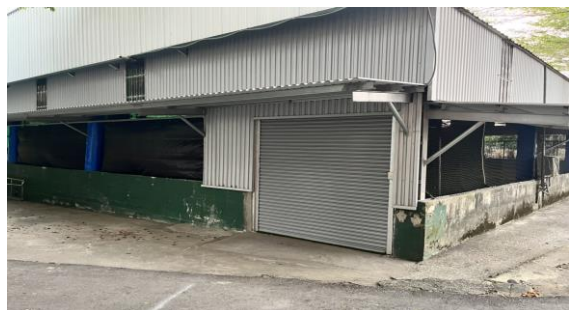
說明：遮雨、圍網及大門整建完成
