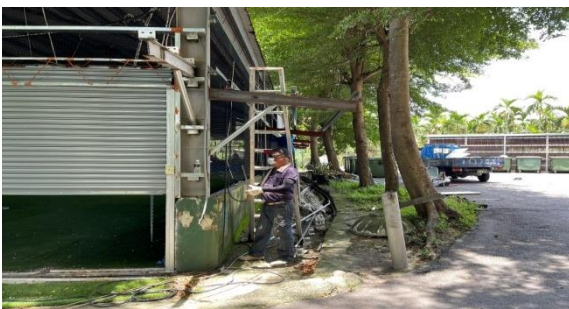
說明：施工情形
