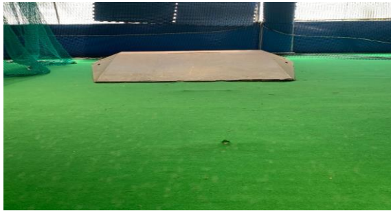
說明：說明破損情形
