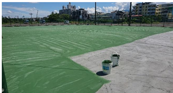
說明：施工情形
