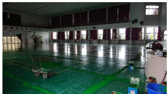
說明：PU 刨除施工情形
