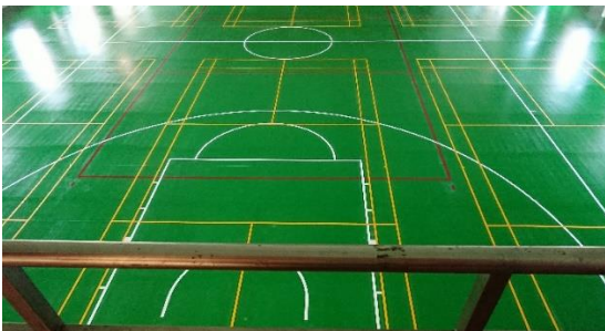
說明：PU 鋪設完成
