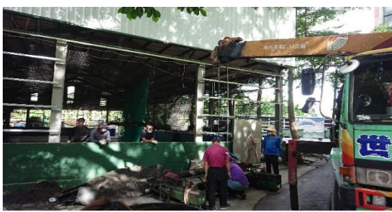
說明：搬運草皮施工
