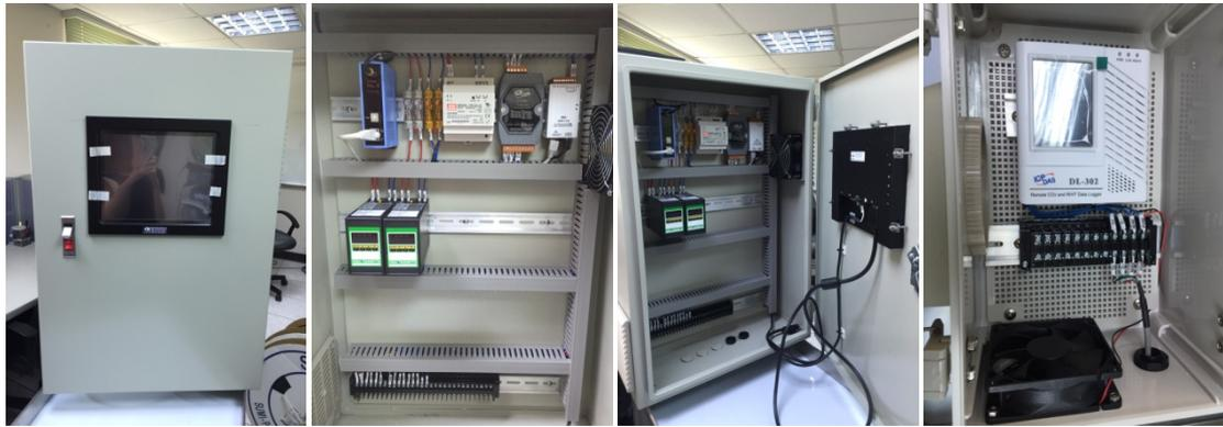
圖八、微型監控系統硬體配置
